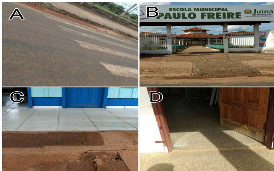
Figura 7 - Entrada da escola e rampas e desníveis no interior da escola Fonte: O autor, 2016.
