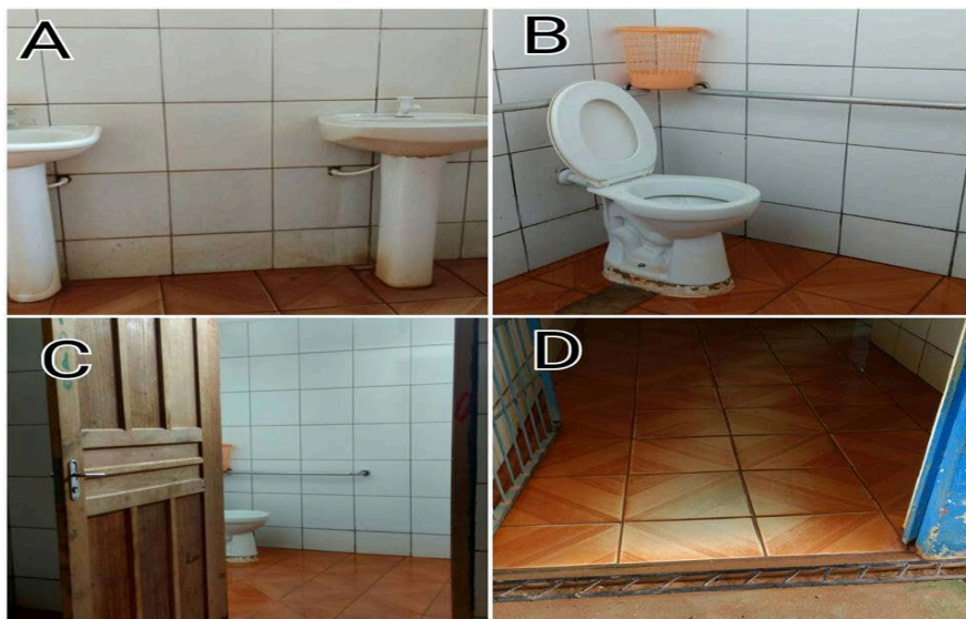
Figura 4 - Banheiro da Escola Fonte: O autor, 2016.
