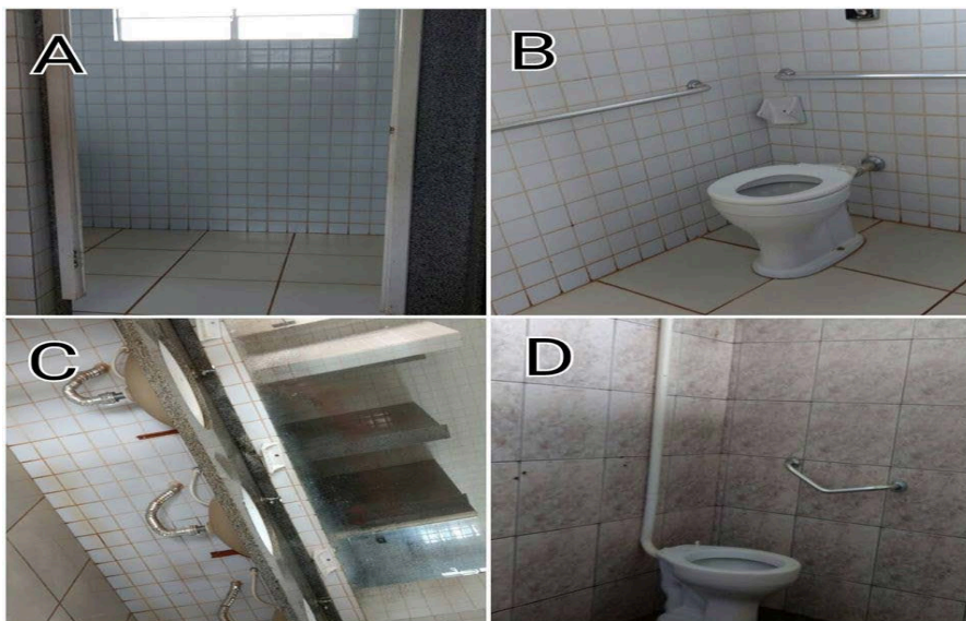
Figura 8 - Banheiros da Escola Paulo Freire Fonte: O autor, 2016.
